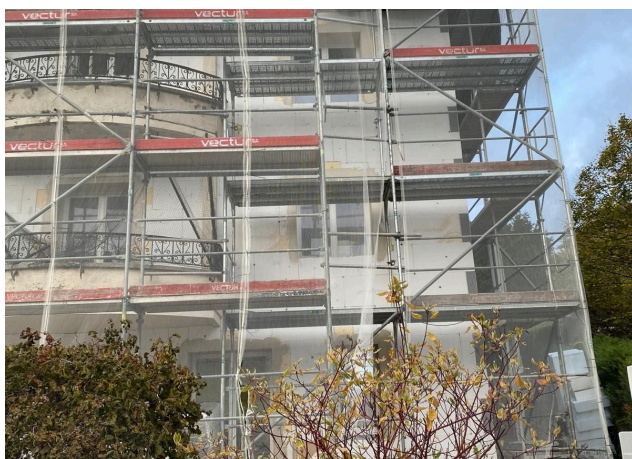
Isolation de façade, pendant le chantier
