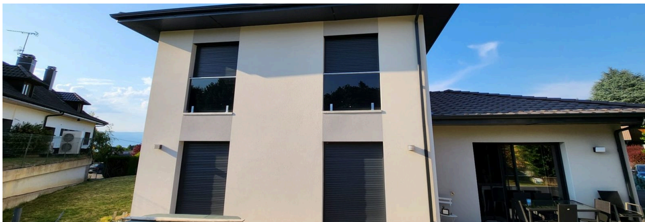
Une façade refaite par nos équipes
